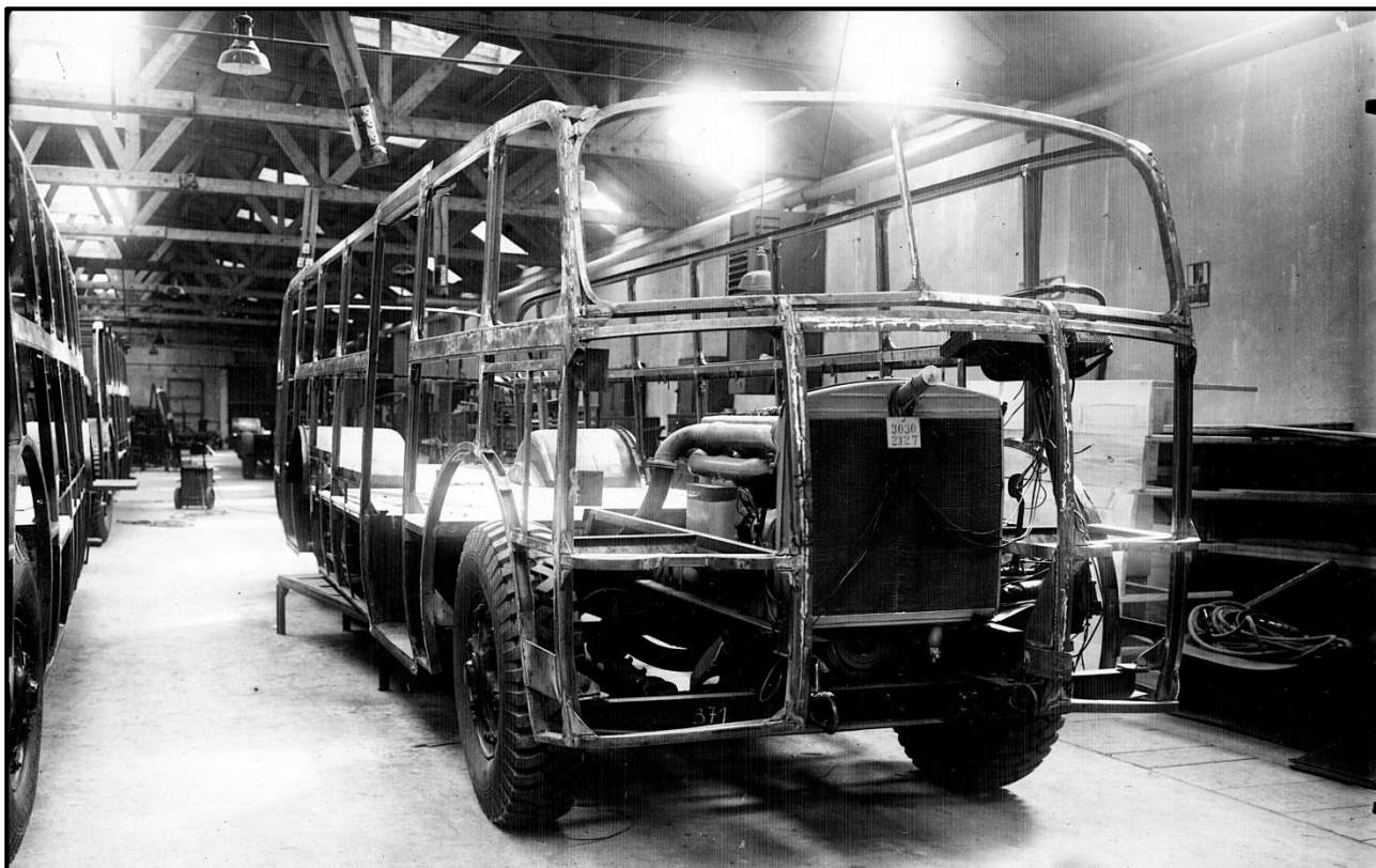
Výrobní hala provozu 110 – klempírna, kam byla přemístěna výroba hasičské techniky. Na obrázku autobus Škoda 706 RO
